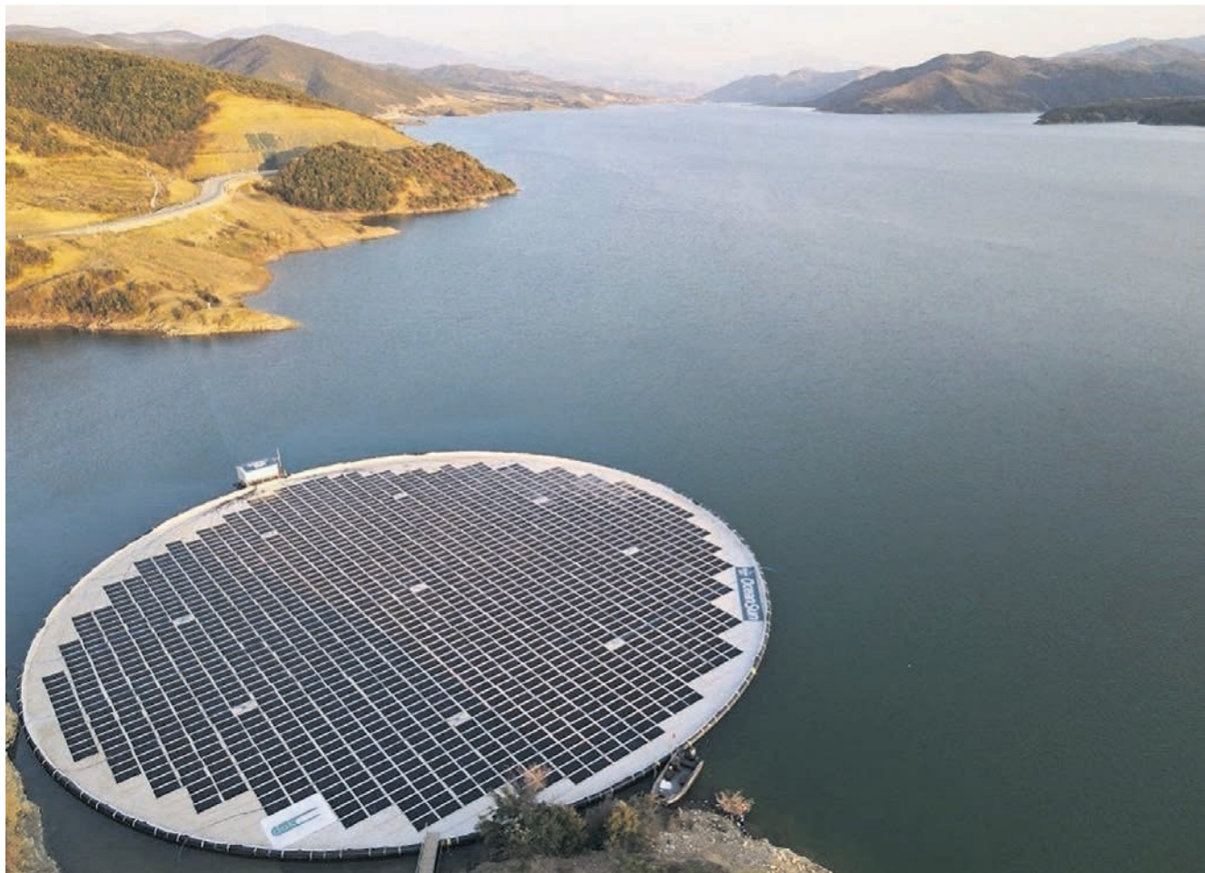
Das norwegische Unternehmen Ocean Sun AS stabilisiert durch Wasserkühlung die Effizienz von Solarmodulen, die bei hohen Temperaturen sinkt. Die Technologie wird auch zum Beispiel in der Energieerzeugung von Meerwasser-Entsalzungsanlagen eingesetzt. In Trinkwasserseen trägt das System dazu bei, dass das Wasser bei hohen Temperaturen nicht so stark verdunstet.
