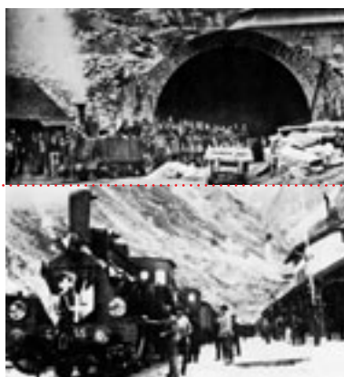
Bau des Gotthard-Tunnels.
