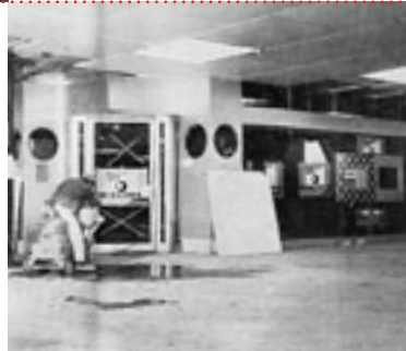
Bau der Filiale der SBG, Zürcher Hauptbahnhof, 1970.
